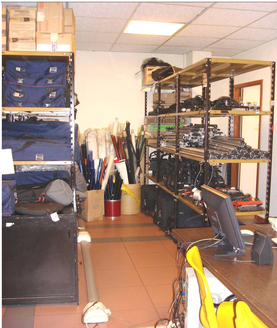
Foto N° 13 – Vista en el 2º piso el interior del depósito de material técnico, en el suelo se puede observar cables de electricidad que corren bajo una cobertura de plástico y alimentan dos grupos de tomas de electricidad.
