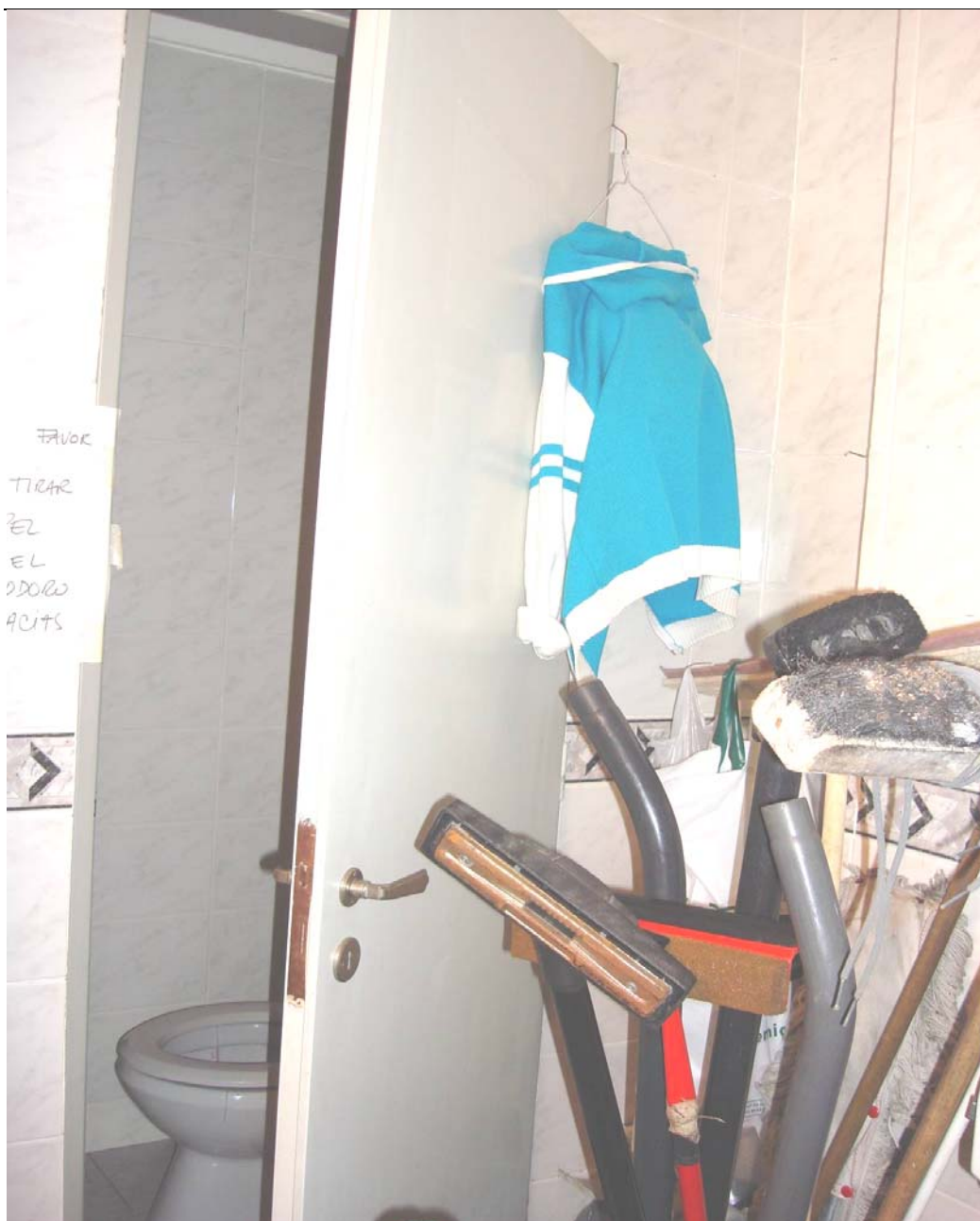
Foto Nº 12 – Vista en el 2º piso el interior de un baño de mujeres, es de notar que el mismo se usa también como depósito de enseres y guardarrobas.
