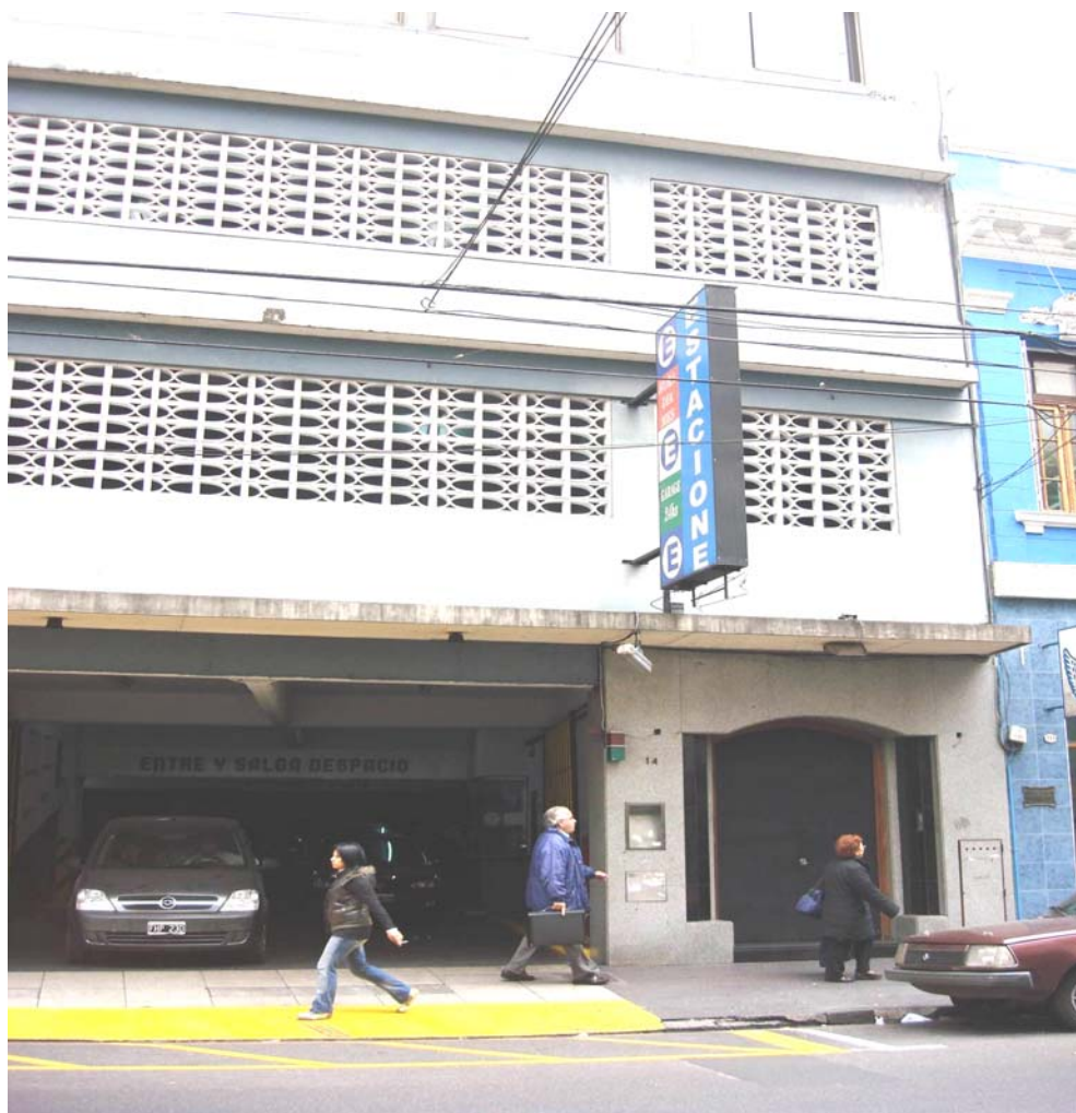
Foto N° 1 – Vista de la entrada del Organismo a la izquierda en la parte superior se puede apreciar la cámara de video para control de este acceso, el mismo no tiene rampa para acceso de discapacitados, a la izquierda la entrada al garaje que forma parte del mismo edificio.
