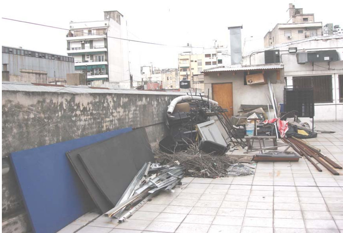
Foto N° 17 – Vista en la terraza del 2° piso materiales en uso y fuera de uso depositados en el suelo de la misma.
