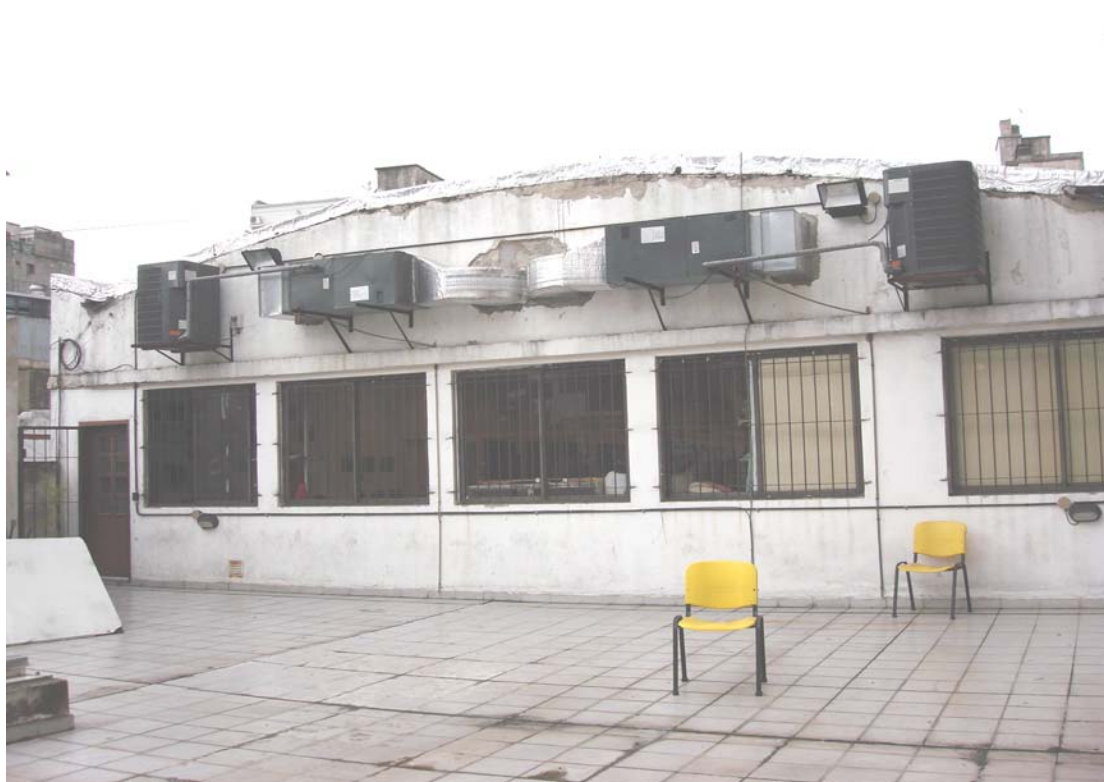
Foto N° 16 – Vista desde la terraza del 2º piso hacia la pared de fondo del salón de las oficinas donde podemos observar las ventanas, los equipos de aire acondicionado y en la pared la cañería por donde corren los conductores eléctricos.
