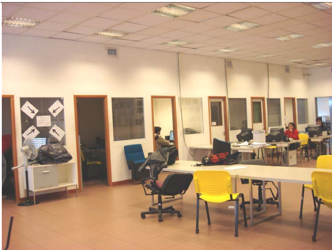
Foto N° 21 – Vista de las oficinas (islas de edición) donde se pueden observar los cables de alimentación de sistemas que bajan desde el sobretecho dentro de una cubierta de plástico duro.
